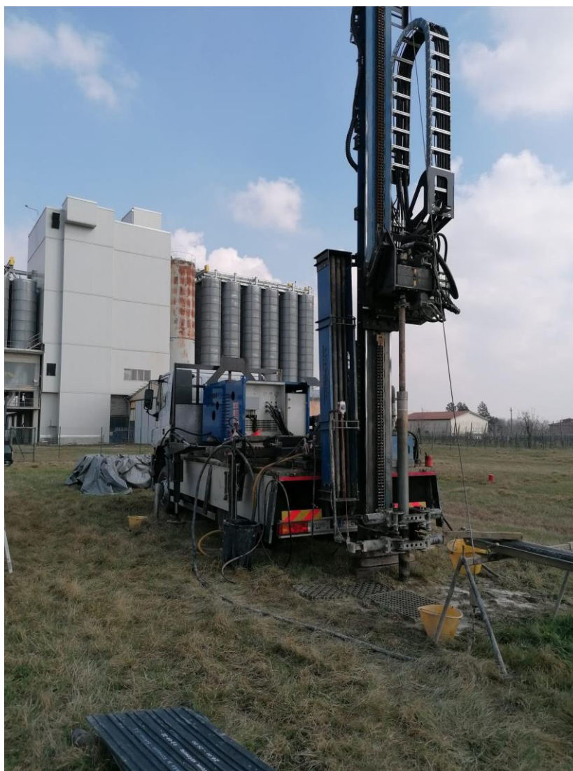
Figura 1: posizionamento sonda per esecuzione sondaggio S1
